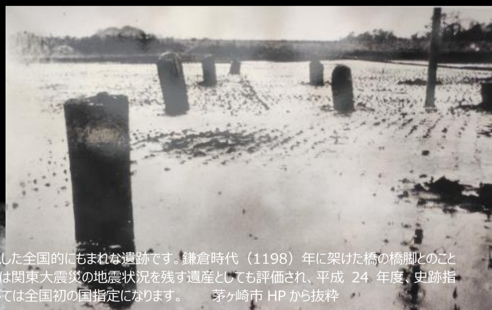
関東地震の液状化による出現時の様子 …史跡後の解説看板に掲載されていた写真
